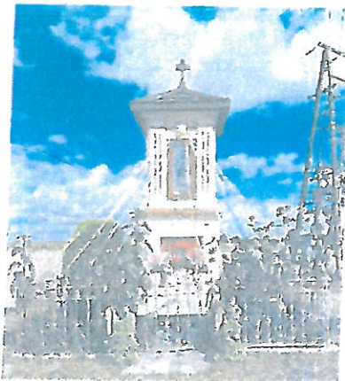
Fot. 1 Kapliczka w Juniewiczych, stan przed konserwacją, widok ogólny, strona frontalna.
