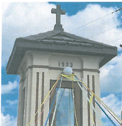
Fot. 3 Górna część kapliczki, widoczne wtórnie zamontowane drewniane okna prostokątne.
