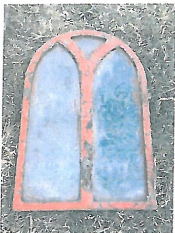
Fot. 2 Kapliczka w Juniewiczach, oryginalne okienko wykonane z metalowych profili pierwotnie umieszczone w niszy części cokołowej.
