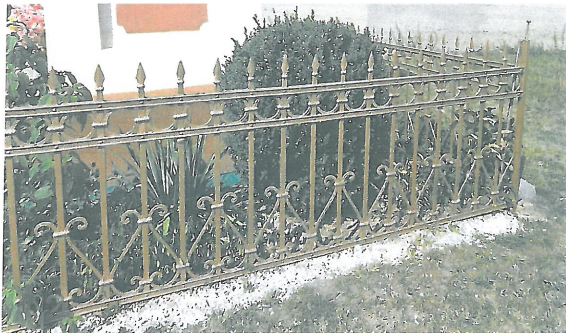
Fot. 5 kapliczka w Juniewiczach, fragment ogrodzenia żeliwnego.
